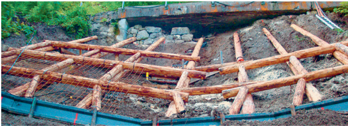
Einbau eines Hangrostes an einer abbruchgefährdeten Böschung.
