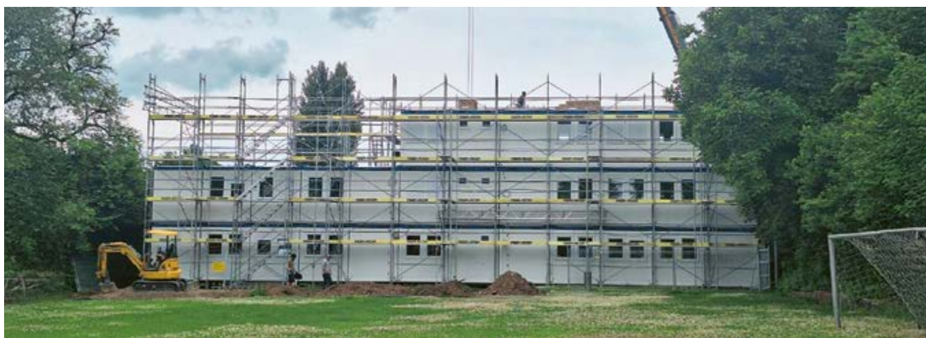
Schulhausprovisorium im Bau
