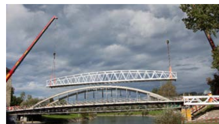
Einsetzen des Fussgängerprovisoriums am 27. September 2024
