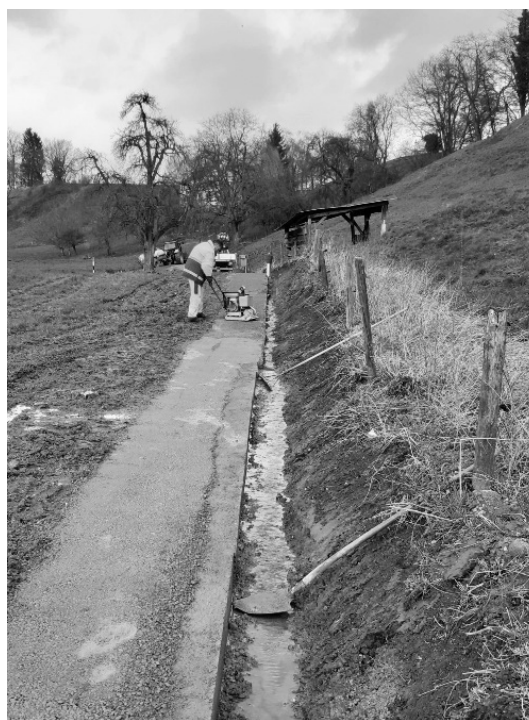
Instandsetzung Entwässerung und Fussweg
