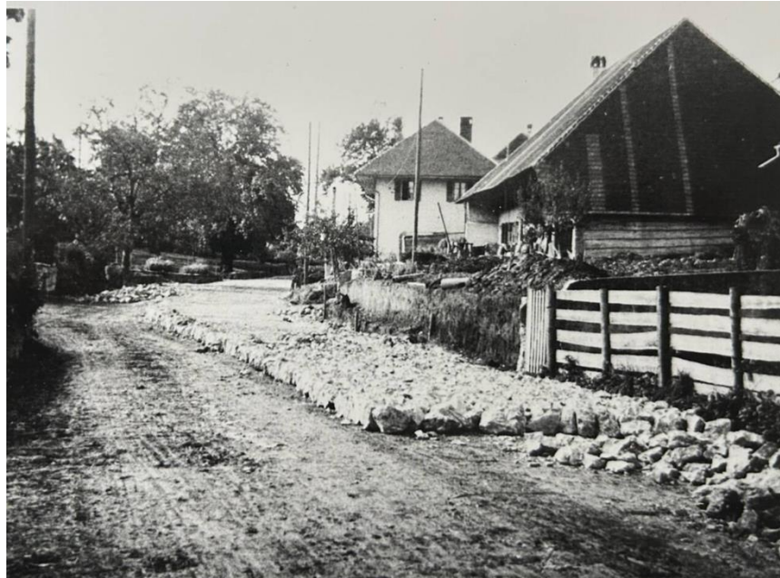
Bau einer asphaltierten Dorfstrasse um 1943/44
