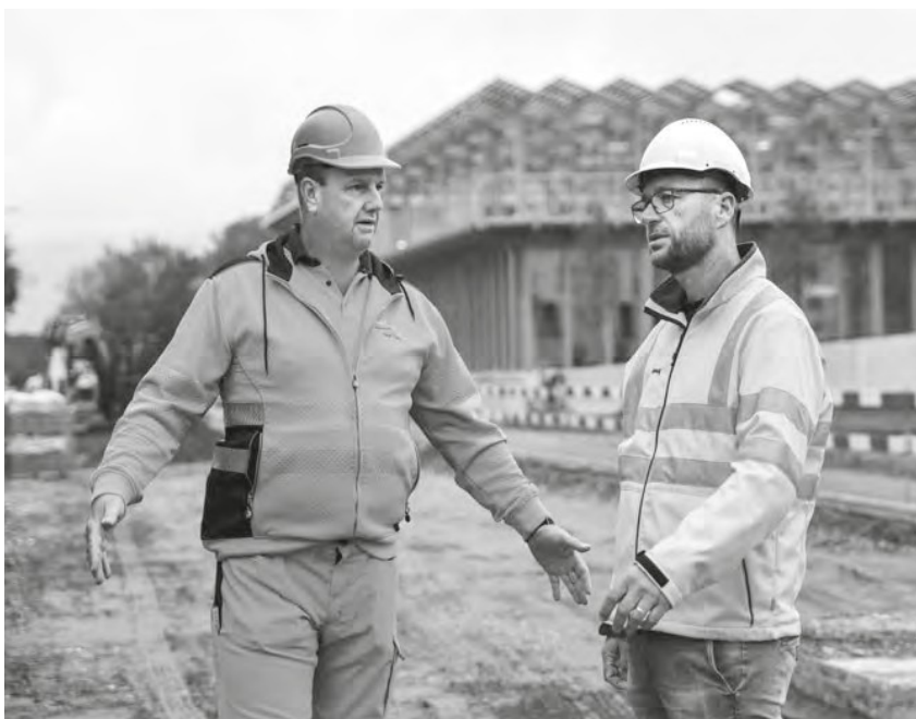
Der Oberbauleiter der Stadt, Beat Cerny (links), im Gespräch mit Shkumbin Gashi von der Firma W. Kressig AG auf der Baustelle im Hanfland
