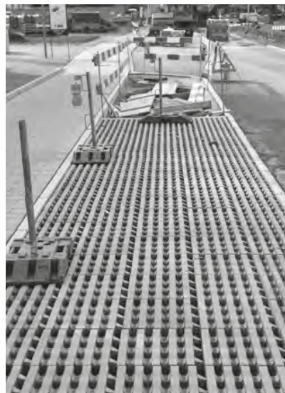
Durch die Rasenliner der Längsparkierfelder entlang der Strasse kann das Wasser versickern.
