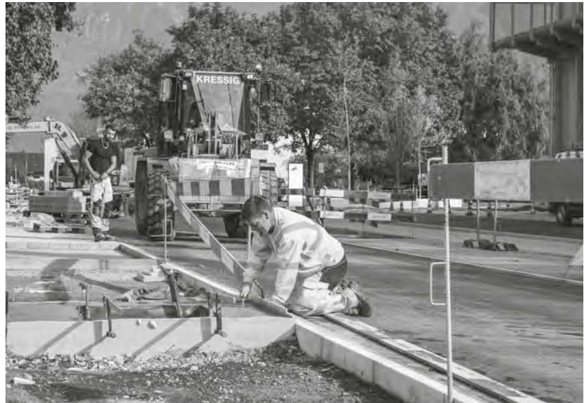
Die Bauarbeiten an der Werdenbergstrasse sind bisher plangemäss vorangekommen.
