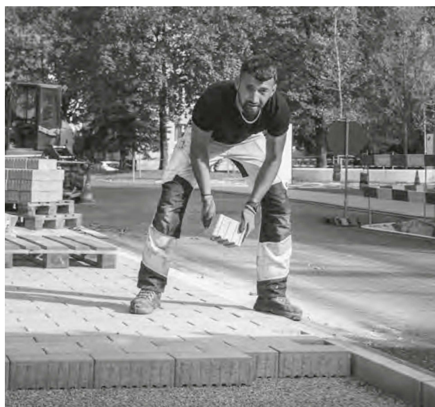
Ein Arbeiter verlegt die versickerungsfähigen Verbundsteine eines Trottoirs (Bild links) entlang der Werdenbergstrasse. Das EWB verlegt neue Leitungen (Bild rechts).
