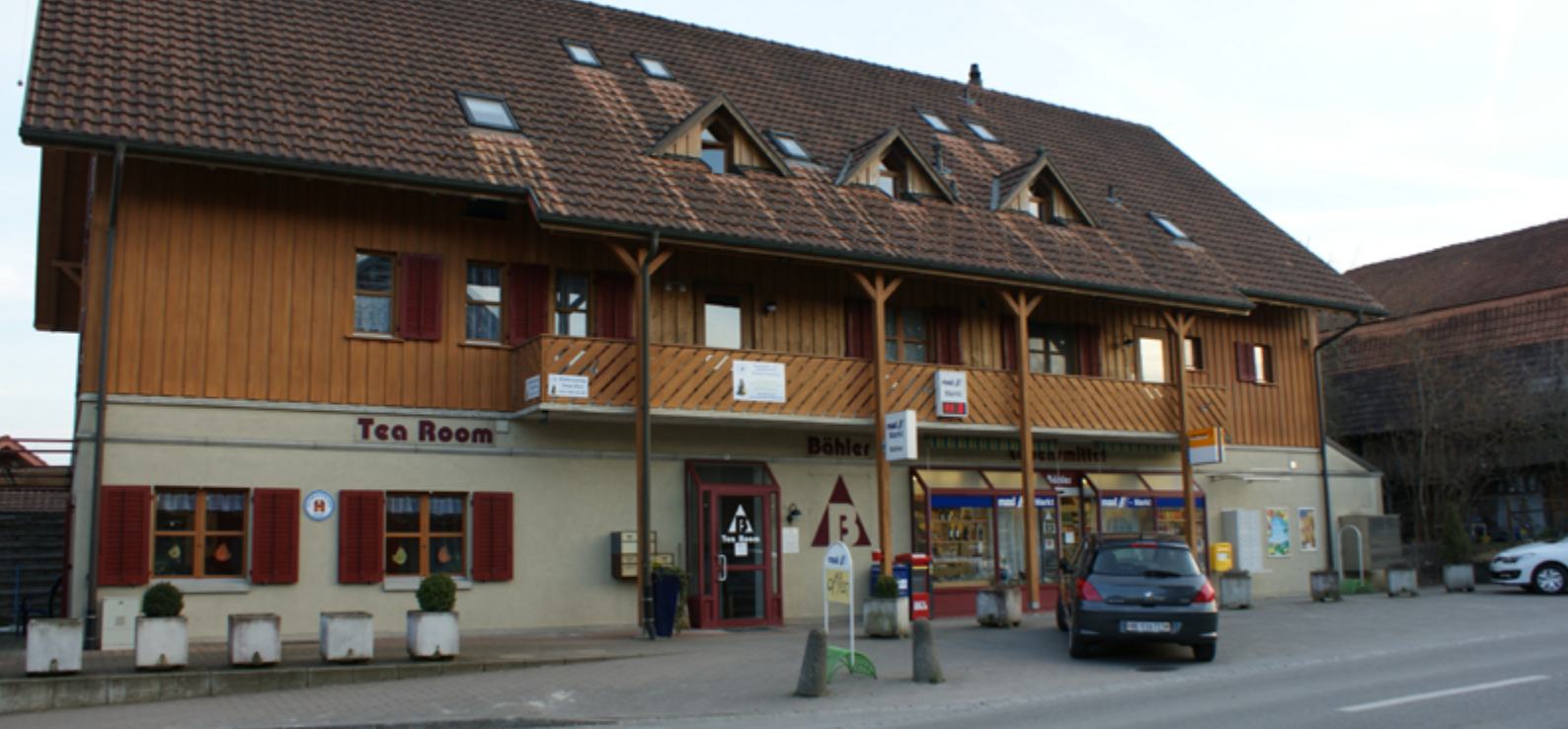
Neubau Dorfladen mit «Tea Room» 1987 an der Hauptstrasse 19
