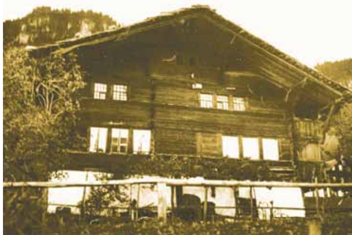
Das Heidenhaus vor dem Abbruch
