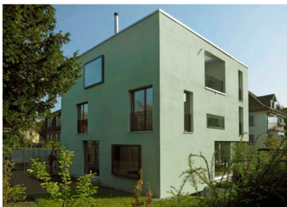
Wohngebäude mit drei Vollgeschossen ...
