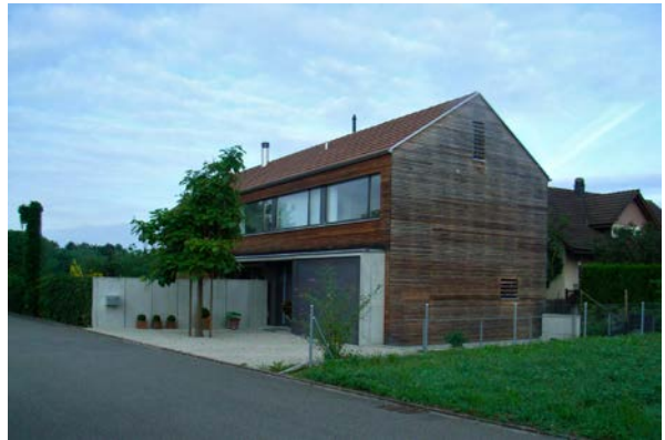
Gutes Beispiel für Neubau am Oberdorfweg
