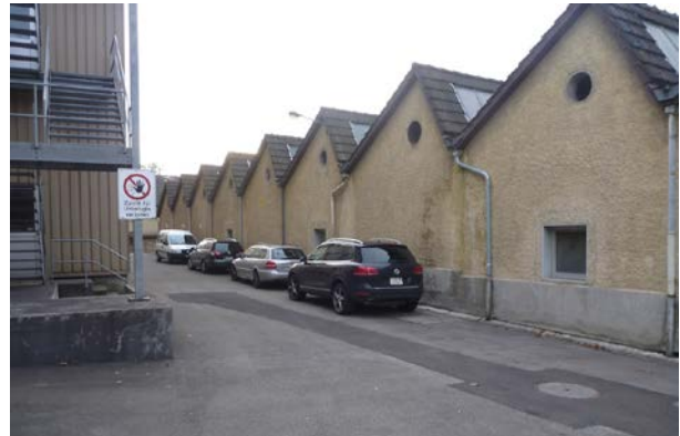
Sheddachhalle mit dem Verbotsschild „Zutritt für Unbefugte verboten“ links davon
