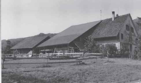
Abbildung 14 Ansicht von Südwesten (Quelle: Kommunales Inventar, 1987)
