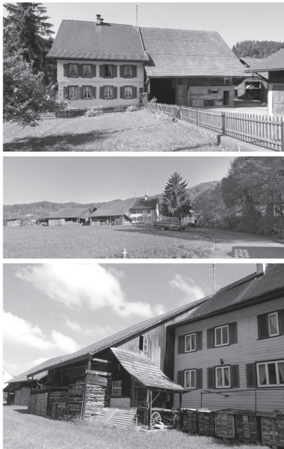
Abbildung 13 Bild oben: Sicht auf Nordostfassade (Blick nach Südwesten; eigene Aufnahme); Bild Mitte: Sicht auf Südwestfassade (Blick nach Osten; Quelle: Google Earth, 2022); Bild unten: Anbau (Blick nach Norden; eigene Aufnahme)
