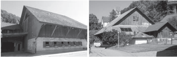
Abbildung 17 Ehemaliges Ökonomiegebäude; Bild links: Sicht auf die Ost- und Nordfassade (Blick nach Südosten); Bild rechts: Sicht auf Südfassade mit kantonalem Denkmalschutzobjekte Reformierte Kirche im Hintergrund (Blick nach Norden, PLANAR)
