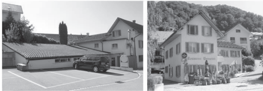
Abbildung 9 Bild links: Kegelbahn mit Parkplatz (Blick nach Süden); Bild rechts: Gastwirtschaftsgebäude an Reppischtalstrasse (Blick nach Nordosten) (PLANAR)
