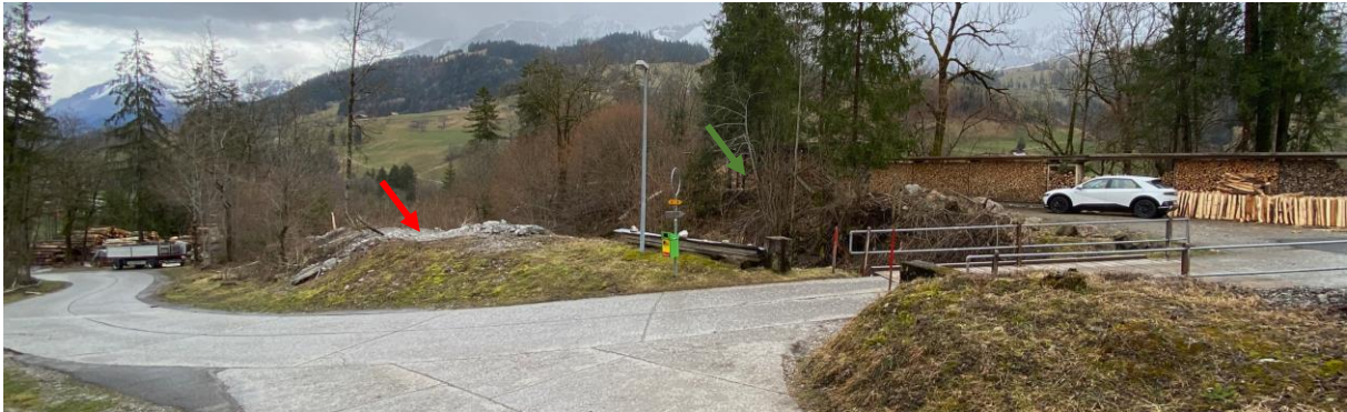
Blick auf Kreuzgasse mit Abflusshindernissen: Dammschüttung (roter Pfeil) und Altlastenstandort (orange)
