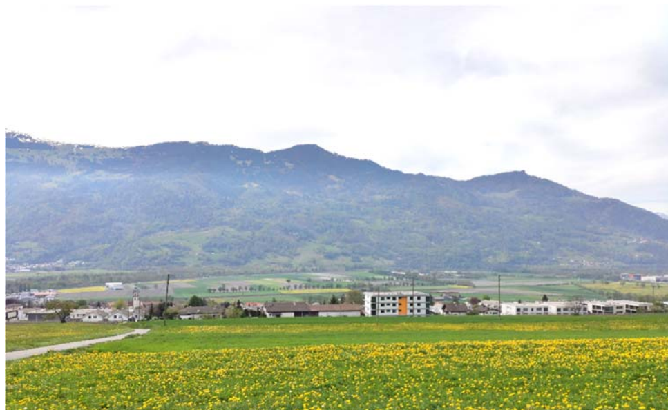
Abbildung: Ansicht Bergseitig; R+K
