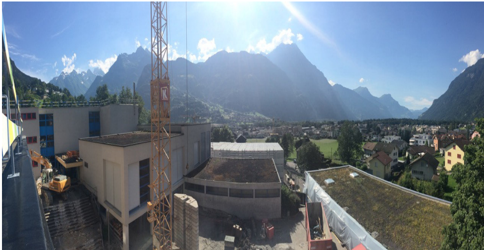
Baustelle Schulhaus Gräwimatt
