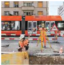
Nouvelle étape pour le chantier de la Rue de Carouge
