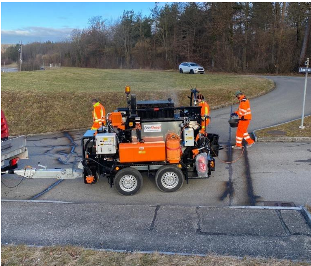
Abbildung 1: Oberflächenbehandlung/Rissanierung an der Austrasse
