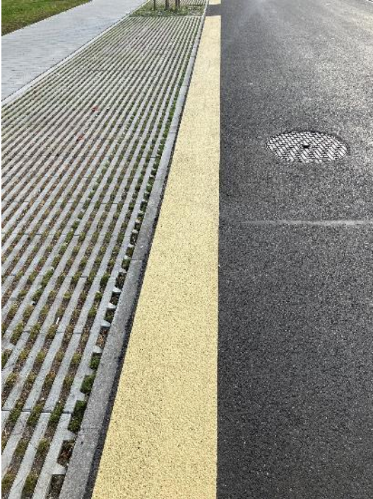
Beispiel bei Werdenbergstrasse Ost
