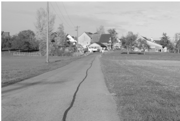
Gemeindestrasse Heimenlachen – Graltshausen
