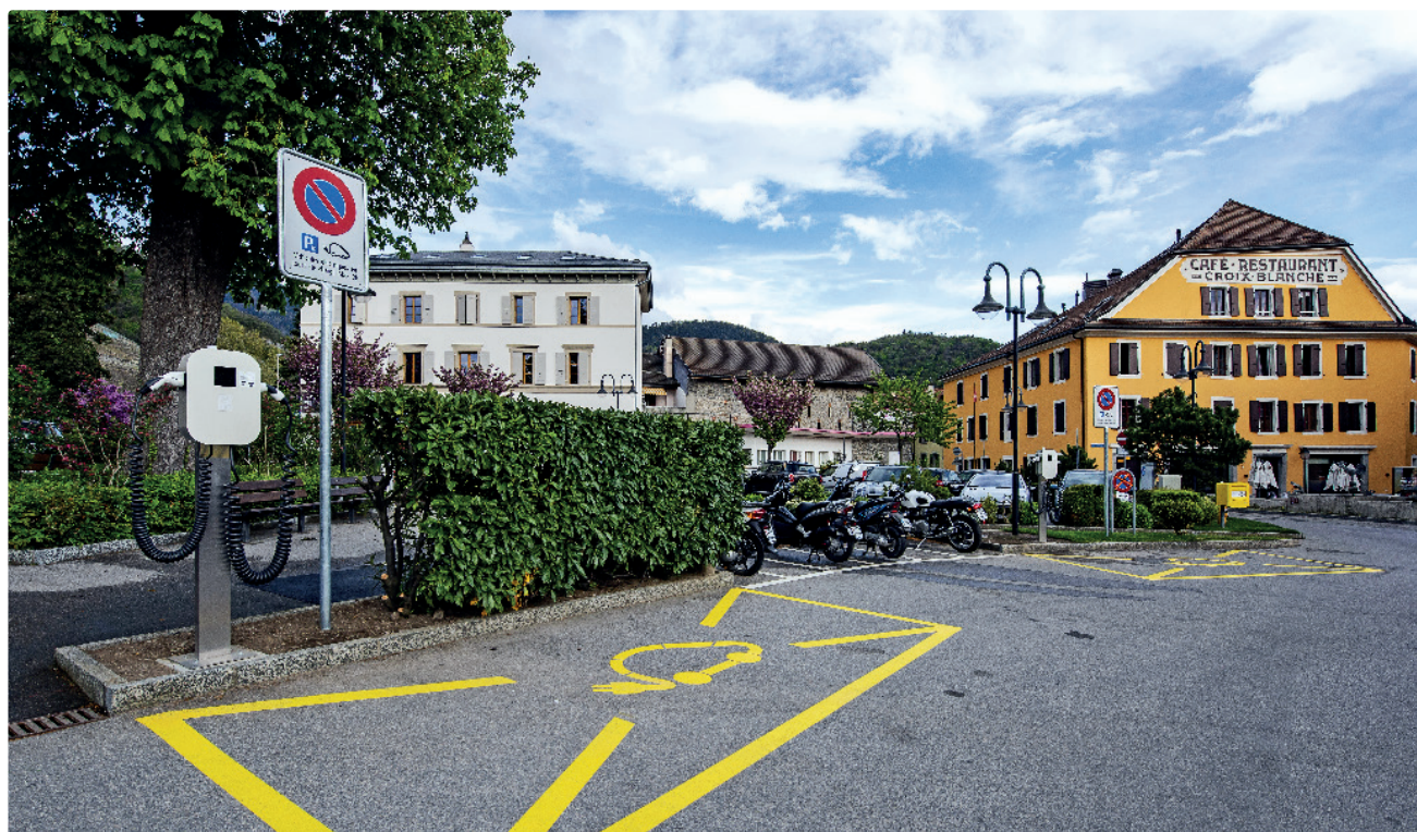
Des bornes de recharge pour voiture électrique ont été installées à la Place Alphone Mex.
