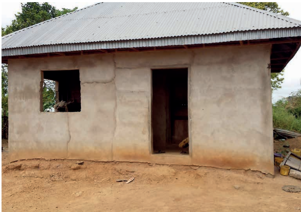
Solche einfache Häuser werden für Witwen gebaut. Dieses ist noch nicht ganz fertig gestellt. [Bild zVg]
