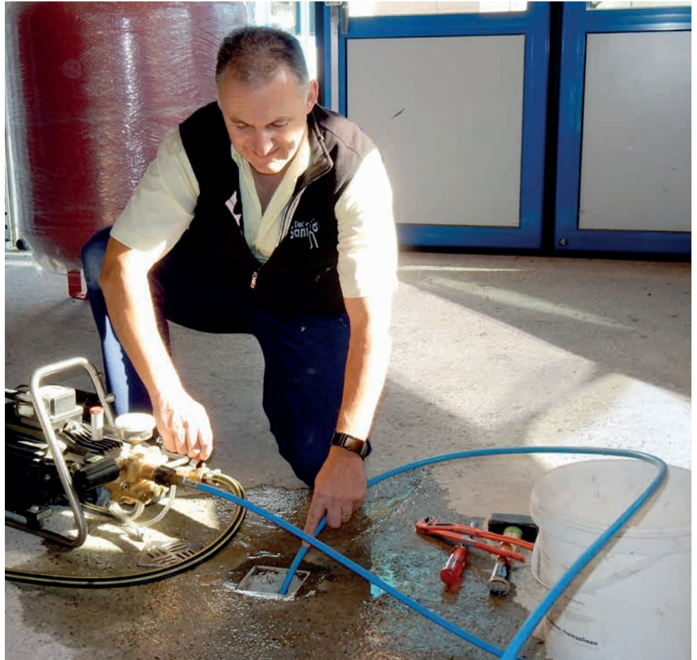
Fredy beim Entstopfen einer Leitung. [Bild fp.]
