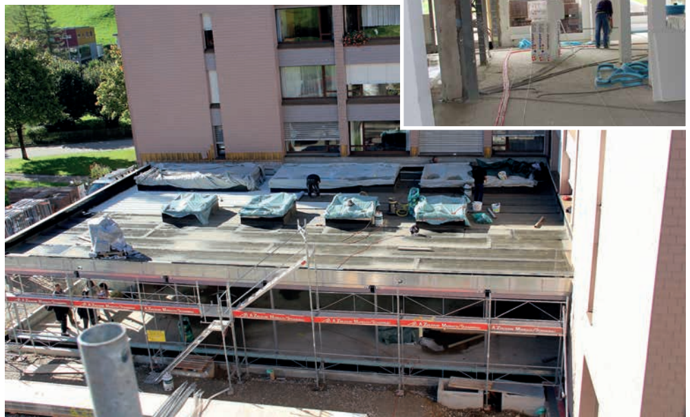
Beim Bau der neuen Cafeteria, der Innenausbau im kleinen Bild. [Bilder zVg]
