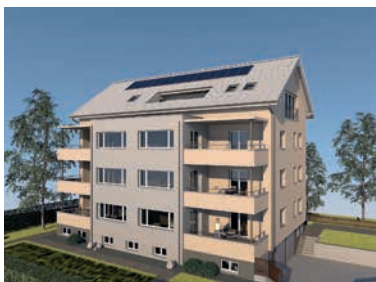
Aktuelles Projekt: Umbau und Renovation MFH in Zürich.
