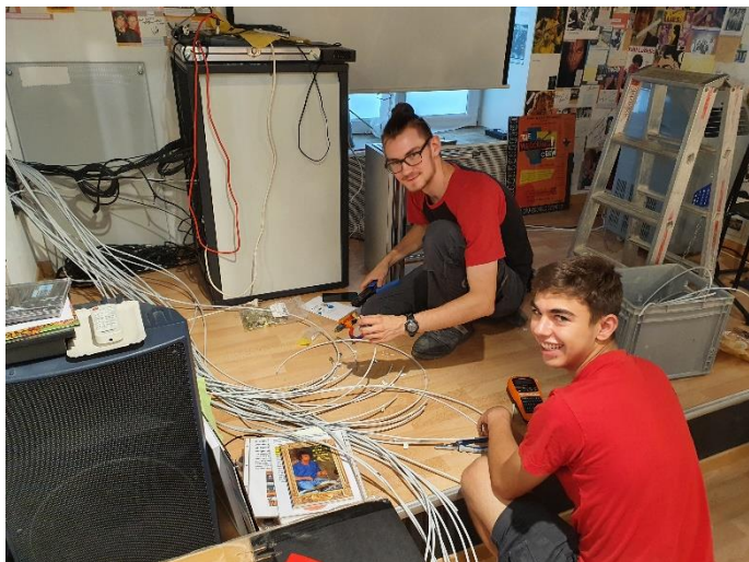
Foto: Mitarbeiter der Helfenberger Elektrotechnik AG bei der Arbeit!
