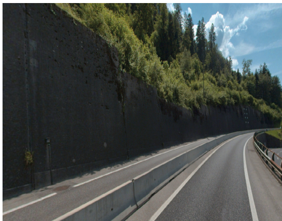
An der Stützmauer wird die Vegetation entfernt, oberhalb wird eine Sicherheitsholzerei durchgeführt.
