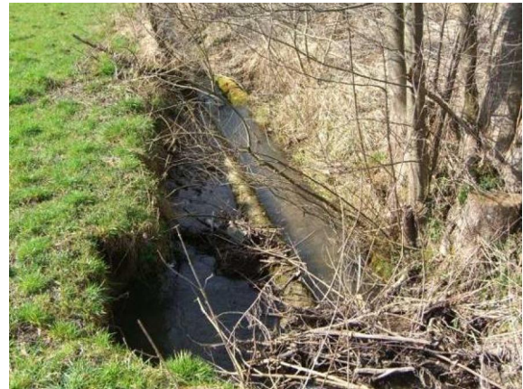
Abb. 2: Hinterspülte Holzlängsverbauungen bei Kote 490
