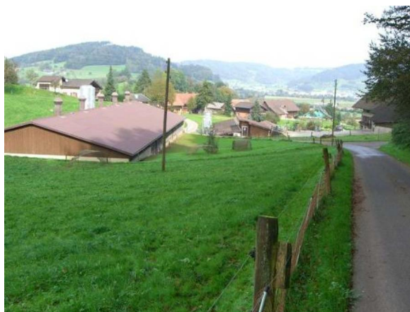
Abbildung 18: Gefährdete Gebäude im Talbodenbereich (Vorder Eichbel, Gde Altishofen) 24.8.2005)
