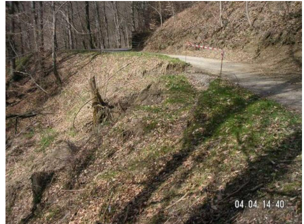
Abbildung 11: Rutschungsanriss unmittelbar am Rand der Forststrasse; ob Stärmel Gde. Dagmersellen (Foto 4.4.2007)
