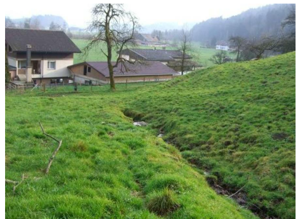
Abb. 2: Eindolung oberhalb Weiler Ellmatt
