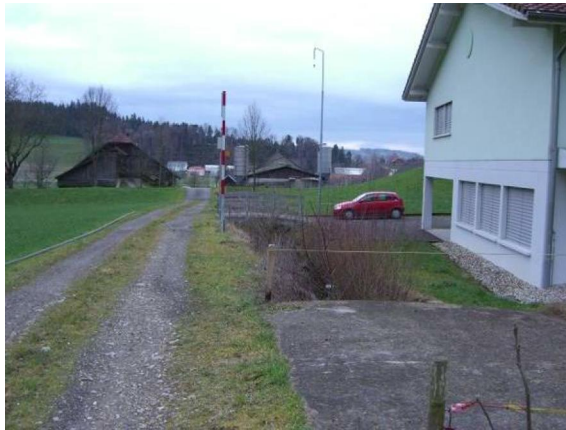
Abb. 1: Ruessgrabe bei Haus Schiessstand oberhalb Erddamm
