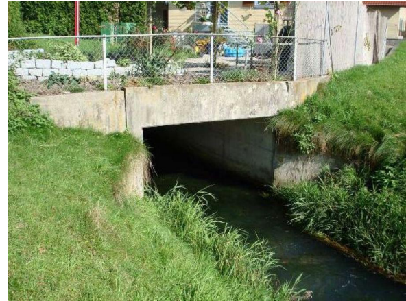
Foto 1 Einlauf Eindolung Kantonsstrasse (Schwachstelle S2)
