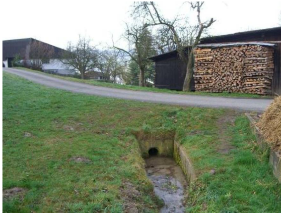
Abb. 1: Eindolung Kote 523 mit kleinem Absetzbecken
