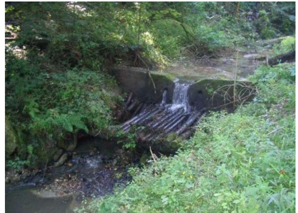
Abb. 2: Absetzbecken vor Eintritt ins Kulturland (Kote 575)
