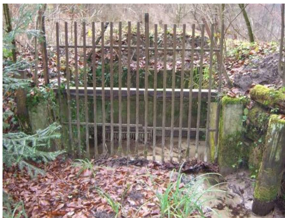
Abb. 1: Eindolung bei Kote 590 m ü.M.
