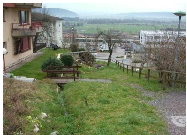
Abb. 2: Gerinne vor Eindolungsstelle bei Kote 530 m ü.M.
