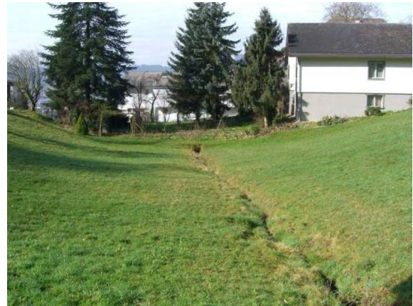
Abb. 2: Gerinne und Eindolung bei Kote 515 oberhalb Siedlungsgebiet
