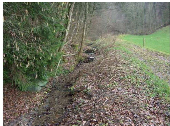
Abb. 2: Schweinibächli oberhalb Unter Flüegge
