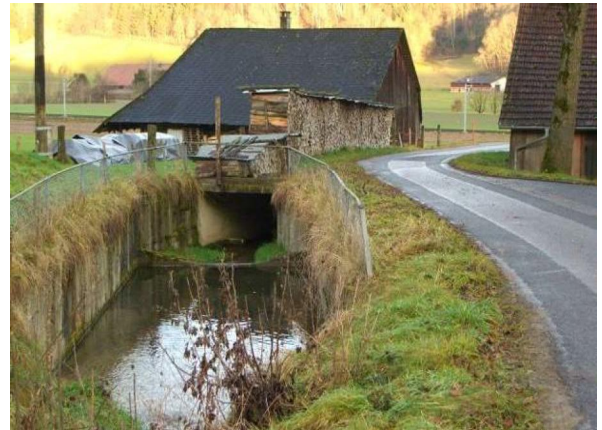
Abb. 2: Eindolungsstelle bei Bodenacher Kote 570 m ü.M.
