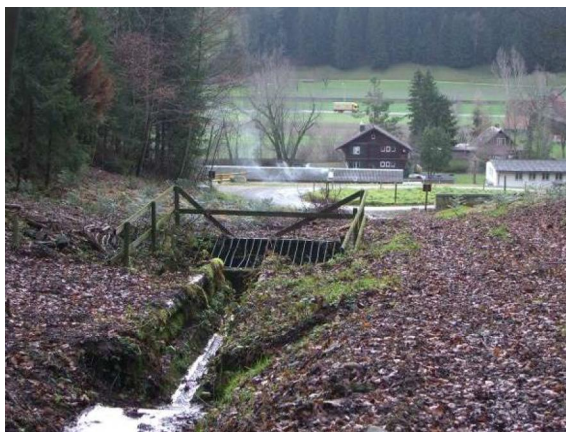
Abb. 1: Eindolung bei Kote 575 m ü.M.
