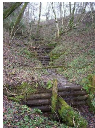
Abb. 2: Holzsperrern oberhalb Eindolungsstelle
