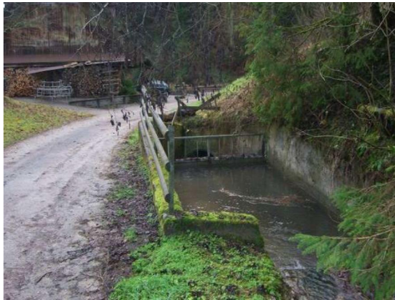
Abb. 1: Eindolung bei Steibruch 585 m ü.M
