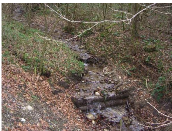
Abb. 1: Holzsperren vor Übergang ins Kulturland
