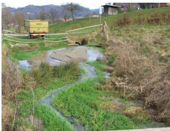
Abb. 1: Durchlass mit Absetzbecken bei Kote 480
