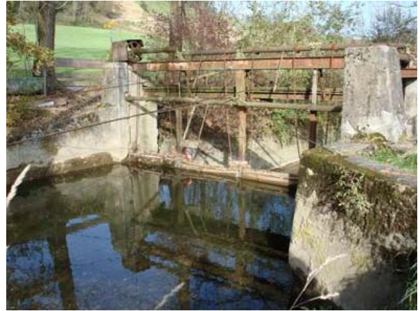
Foto 1 Baufälliges Wehr Gettnau (Schwachstelle L2)
