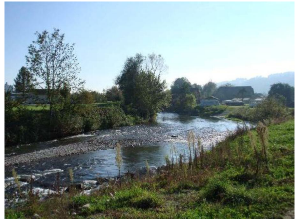
Foto 2 Aufweitung Schmidwinkelmatte (Blick gegen die Fliessrichtung), beabsichtigte Wasseraus- tritte auf orographisch linke Seite (im Bild rechts) (Schwachstelle W10)
