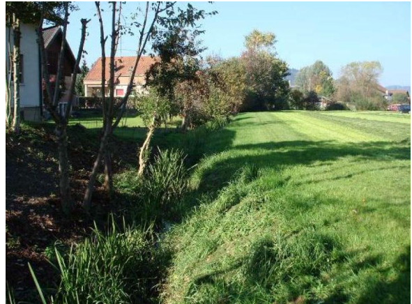
Foto 1 Ungenügende Abflusskapazität des Gerinnes, Sandablagerungen und aufkommende Vegeta- tion im Abflussquerschnitt (Schwachstelle B1)
