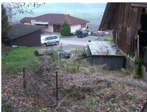
Abb. 1: Strassendurchlass bei Kote 555
