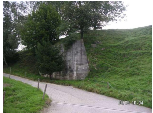
Abbildung 13: Stützmauer an Steilhang zur Sicherung der Strasse; Leingruebe Gde. Reiden (Foto 6.9.2006)
