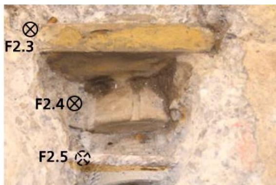
Abbildung 4: UEF AS Buchs – Sondierfenster Vorspannverankerung
