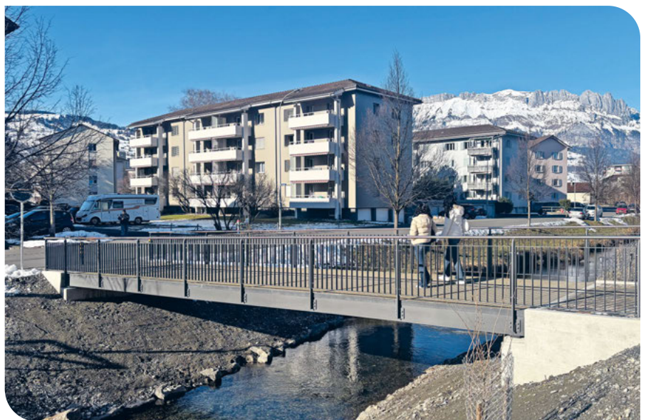
Eine neue attraktive Verbindung und Überbrückung des Giessens: Die neue Fuss- und Veloverkehrsbrücke «Kornstrasse»
