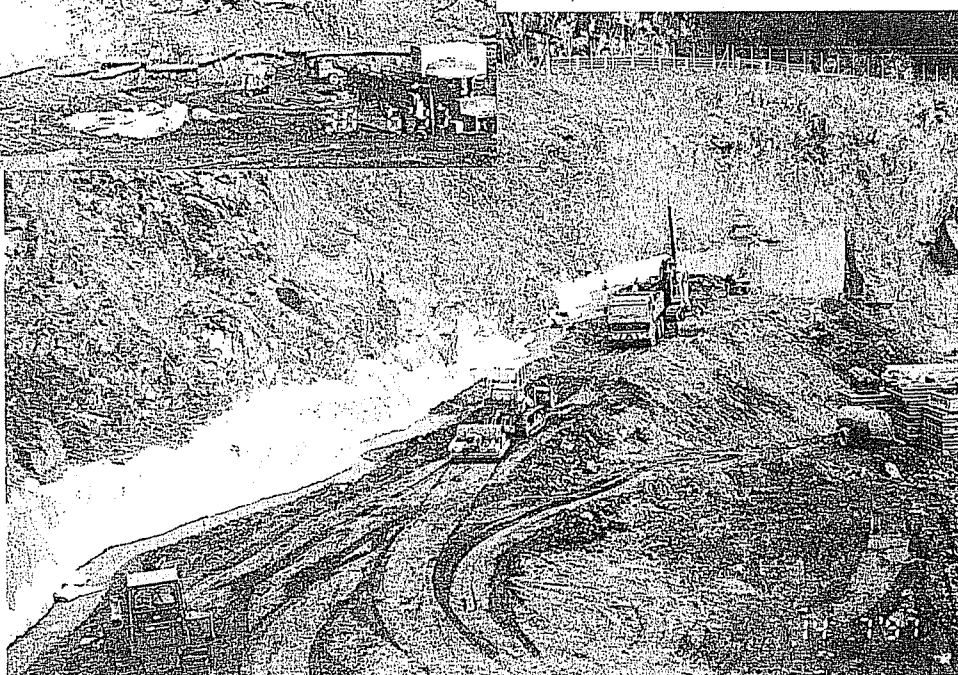
Umlagerung und Einbau der bestehenden Altlast auf den bereits abgedichteten Teilbereich.
