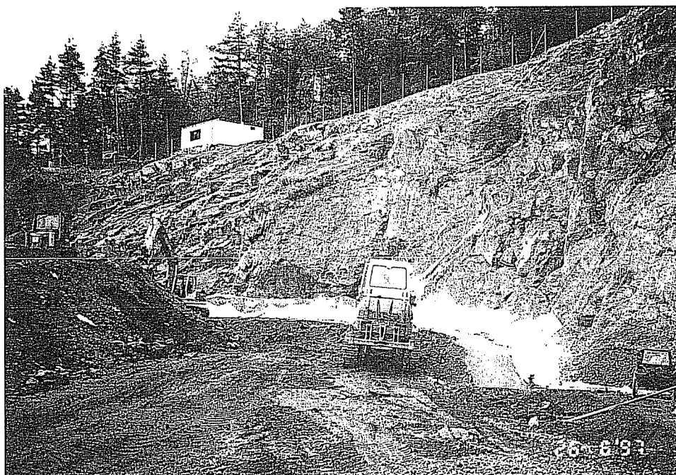
Einbau der mineralischen Randabdichtung.
