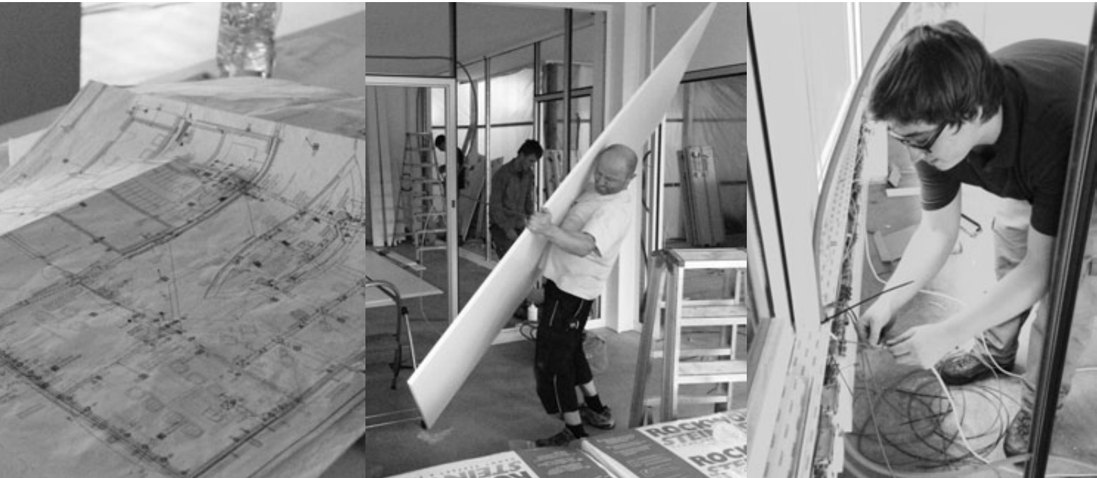
Hochbetrieb bei den Installations- und Baufirmen, die das zeitgemäss ausgestattete Frontoffice der Gemeindeverwaltung Buchs in Rekordzeit erstellen.
