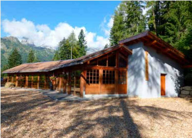
Réfection et agrandissement du couvert de Tourbillon
