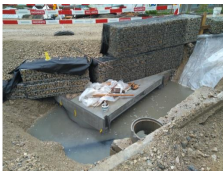
Mise en place de gabions
