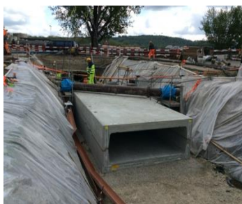
Vue sur le ponceau et la conduite d'eau usée via la step
