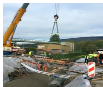
Vue des différentes conduites avant démontage
