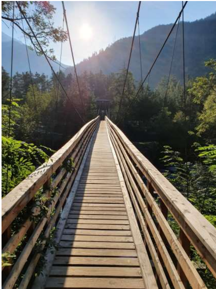
Hängebrücke (nach Sanierung) in Blickrichtung Sils i.D.
