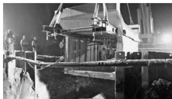
Kurz nach Mitternacht: Das mittlere Element der Unterführung wird in die Baugrube versenkt.
