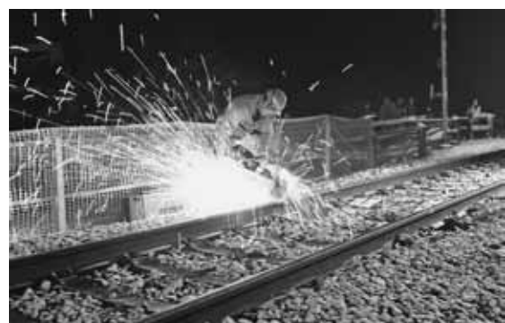
Es ist kalt und schneit leicht. Funken sprühen. Schweißer trennen zum Ausheben der Baugrube ein Stück Gleis samt Schwellen ab.
