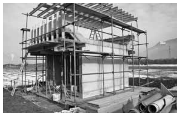
Der vorgefabrizierte Mittelteil der künftigen Bahnunterführung «Ackerweg» wird ausserhalb des Bahntrassees für den Einbau vorbereitet.
