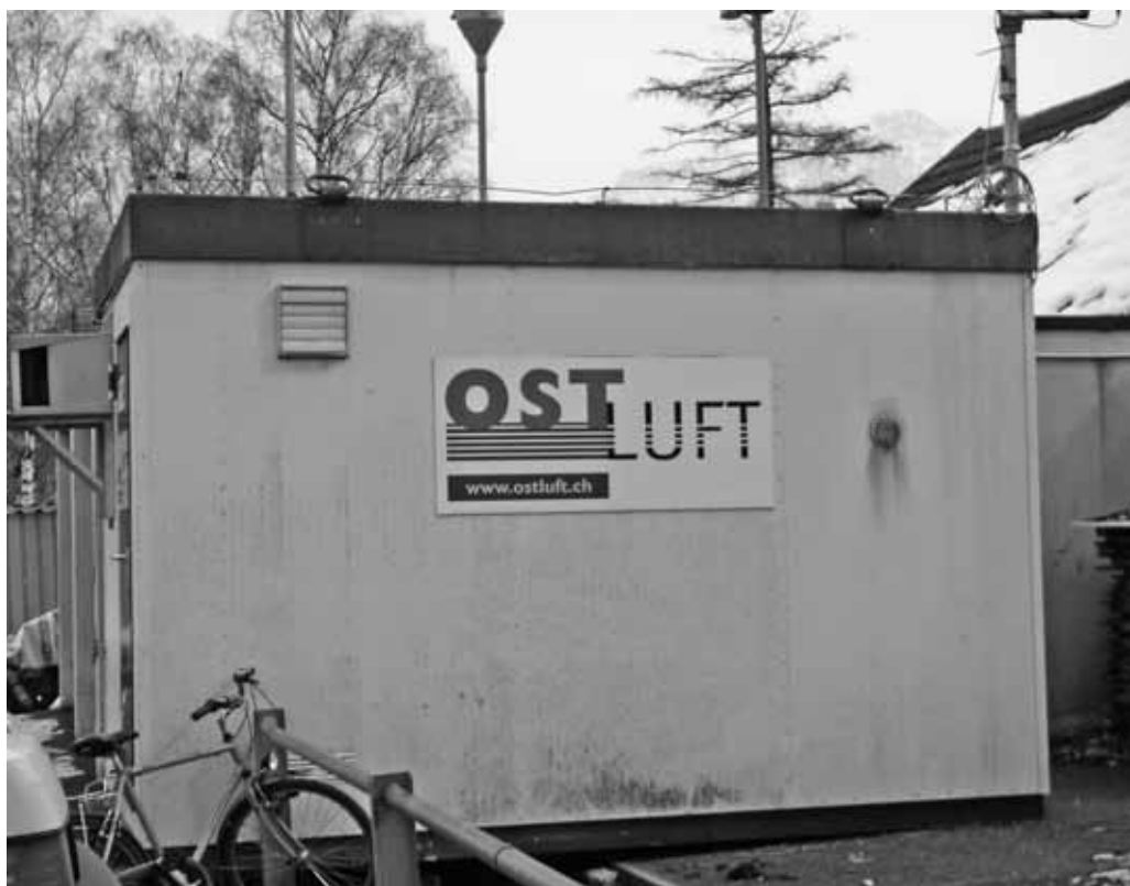
Luftmessstelle Ostluft, sie misst rund um die Uhr die Qualität der Luft.
