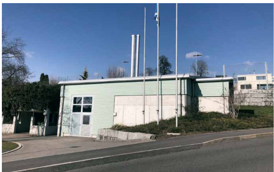
■ Heizzentrale der gommisWALDKraft AG.
