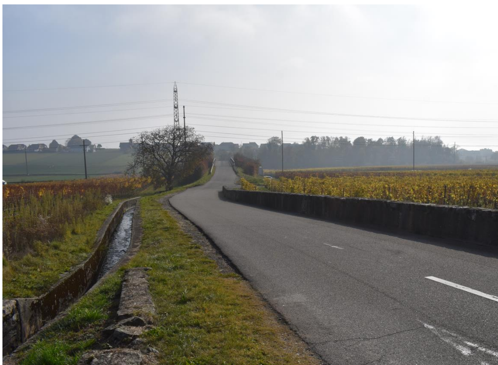
Figure 15: Vue de la route de Bougy, côté Jura (Surveillance de l'ouvrage du 27 octobre 2022)
