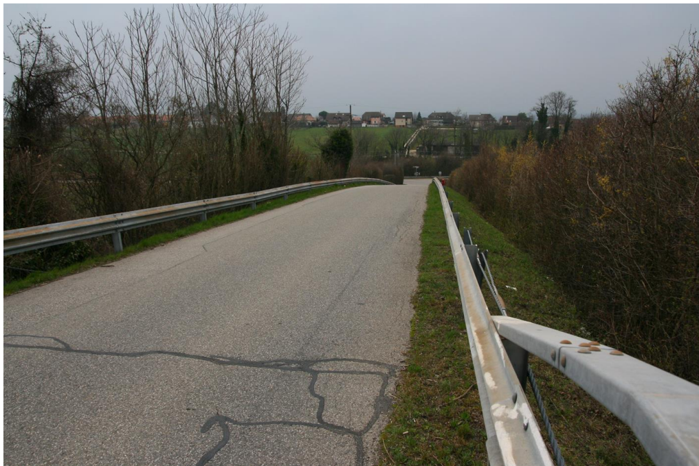
Figure 14: Vue de la route de Bougy, côté Lac (Surveillance de l'ouvrage du 27 octobre 2022)
