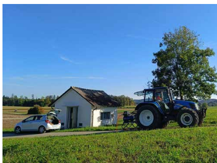
Inbetriebnahme des Zapfwellengenerators durch die Wasserversorgung Dinhard.
