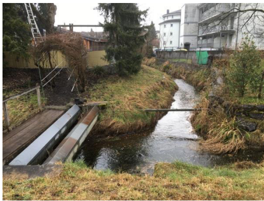
Einmündung in den Wettibach (gegen Fliessrichtung)
