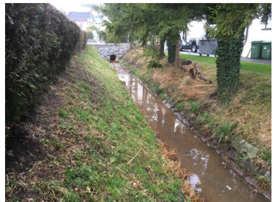
Oberer Abschnitt mit der Einleitung des Meteorwasserkanals (gegen Fliessrichtung)
