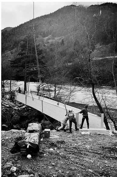
... wurde durch eine neue Holzkonstruktion ersetzt.
