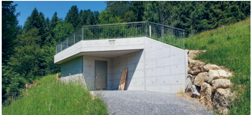
■ Sammel- und Vordruckbehälter Hinterschwendi.
