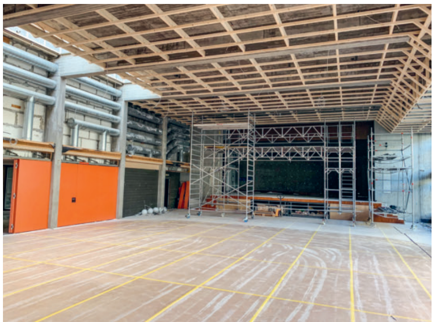
■ Die neue Holzkonstruktion der Decke ist bereits montiert.
