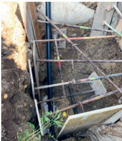
■ Die Anschlussstelle musste wegen der tiefliegenden Wasserleitung gut gesichert werden.
