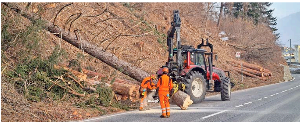
Aufgrund der Baumfällungsarbeiten musste die Kantonsstrasse nördlich von Thusis Anfang des Jahres zeitweise einseitig gesperrt werden.
