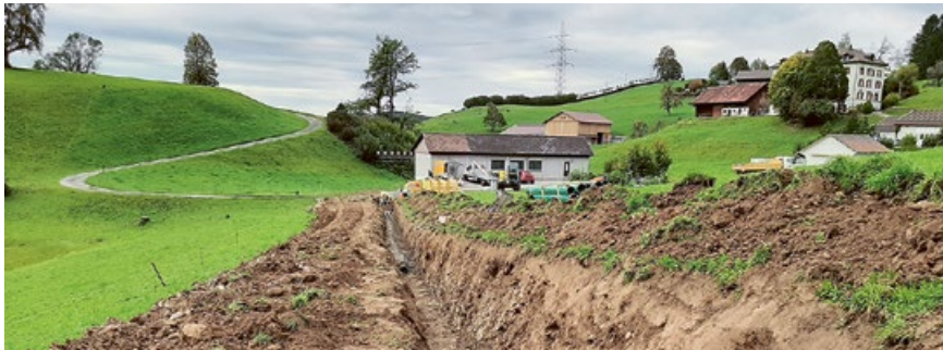
■ Im vorbereiteten Graben wird die neue Schmutzwasserleitung verlegt.
