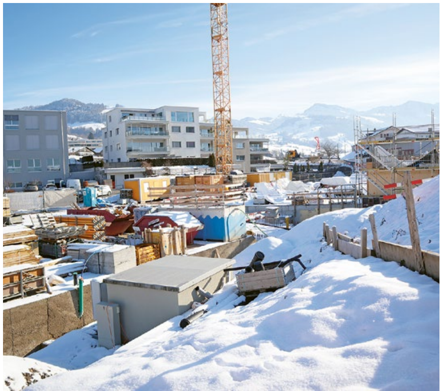
■ Die Baustelle im Winter.
