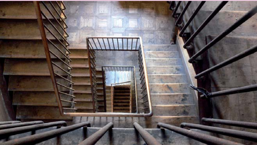
CAGE D'ESCALIER AVANT TRAVAUX
