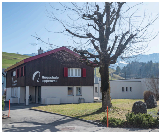
Neu sanierte Gebäude Dorf 3 und 5, Weissbad
