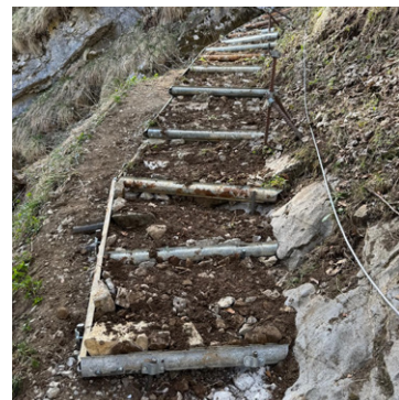
Neue Treppe beim Äscherweg
