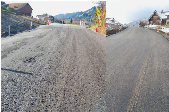
Sanierung Triebenerstrasse, Weissbad
