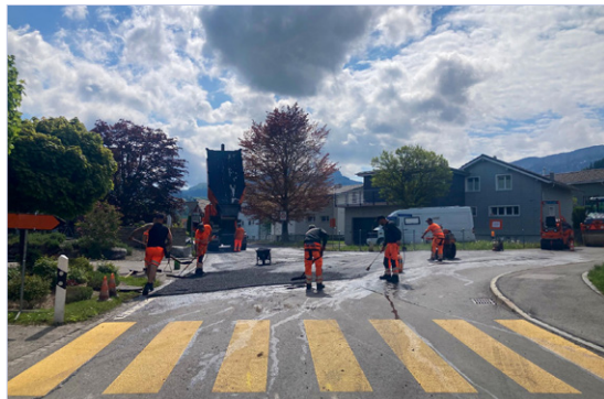
Einbau Deckbelag Nollenstrasse, Appenzell
