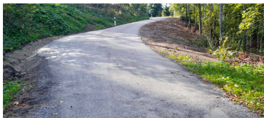
Sanierung Waldstrasse, Eggerstanden
