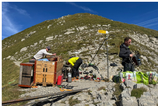
Material bei der Wegsanierung Altmann
