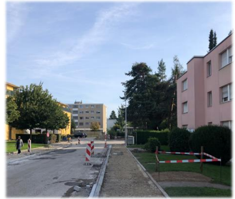
Abbildung 6: Strassenbauarbeiten im Quartier "Im Feld"
