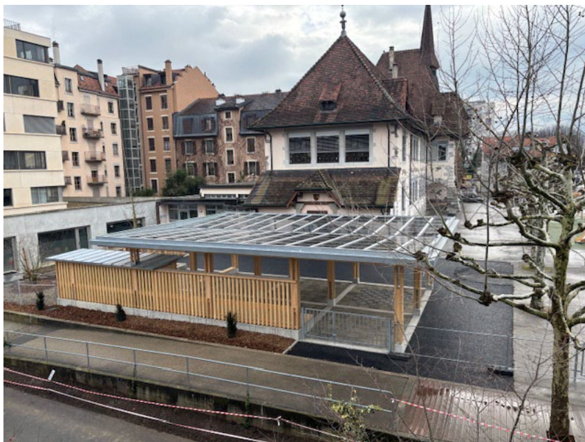
École Place-Favre : vue des panneaux solaires constituant la toiture du préau couvert
