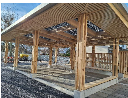
Préau de l'école Place-Favre, détail de la charpente en bois
