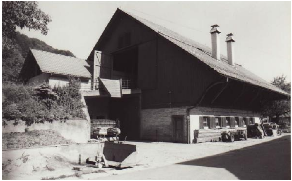
Abbildung 18 Ansicht von Nordwesten (Quelle: Kommunales Inventar, 1987)
