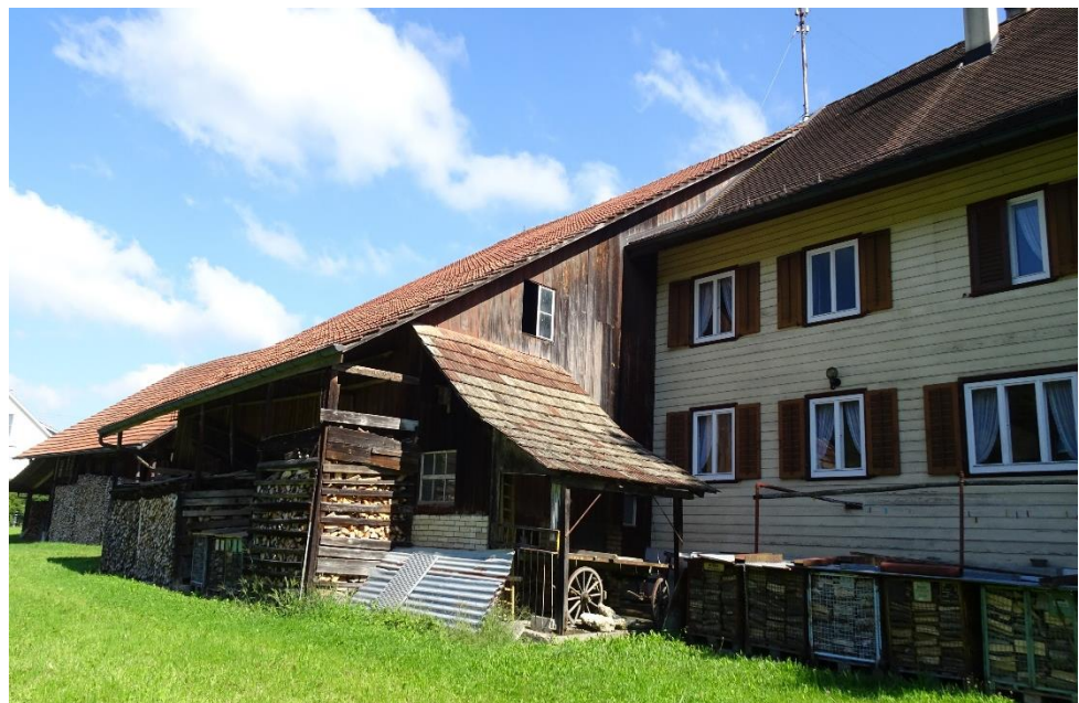
Abbildung 13 Bild oben: Sicht auf Nordostfassade (Blick nach Südwesten; eigene Aufnahme); Bild Mitte: Sicht auf Südwestfassade (Blick nach Osten; Quelle: Google Earth, 2022); Bild unten: An- bau (Blick nach Norden; eigene Aufnahme)
