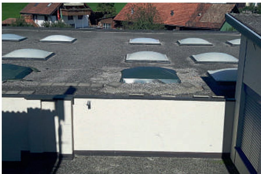
Aussensicht auf Flachdach mit Oblichtkuppeln
