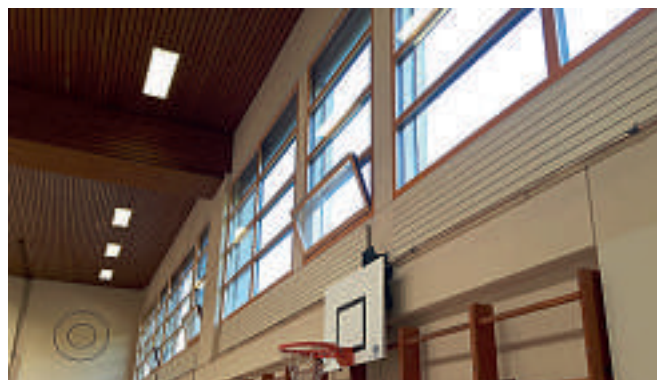
Heutige Fensterfront mit Kippfensterflügeln
