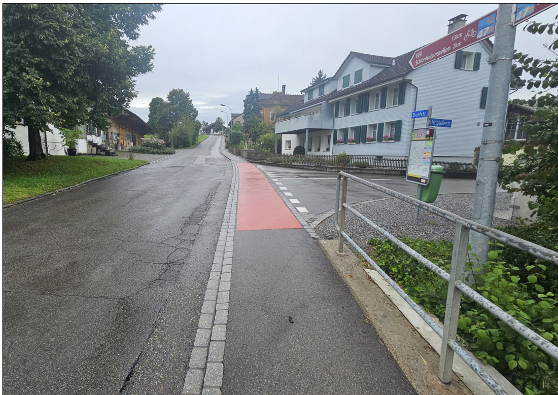
Abbildung 1: Bestehende Dorfstrasse, Blickrichtung Westen (NRP Ingenieure AG, 29.08.2025)
