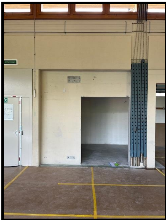
Neue Türe MZH in Abstellraum
