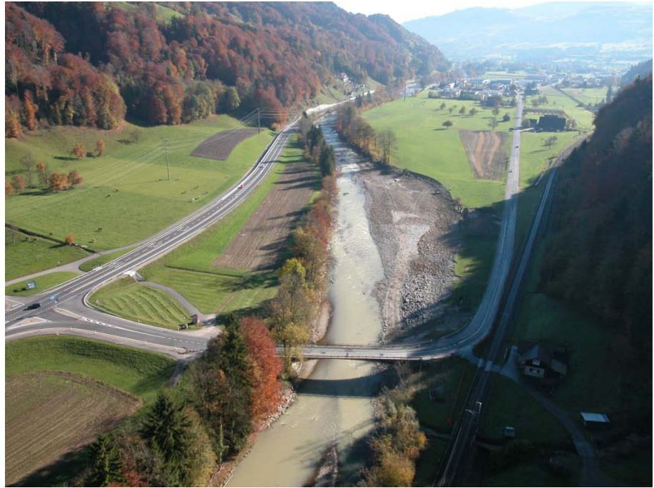
Abb. 38 Kleine Emme Abschnitt 3, Langnauerbrücke – Hochwasser 2005, Blick flussabwärts
