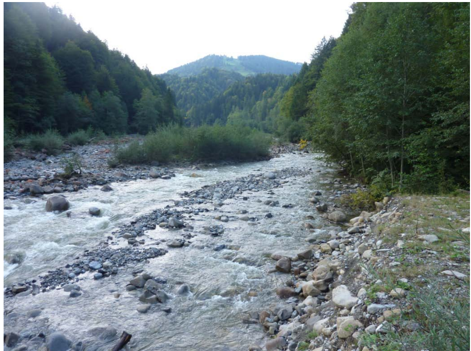
Abb. 91 Grosse Entle Abschnitt 2, oberhalb Schwelle, Blick flussaufwärts
