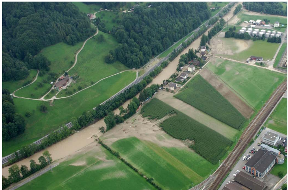
Abb. 39 Kleine Emme Abschnitt 3, oberhalb Zufluss Rümli – Hochwasser 2005, Blick flussabwärts
