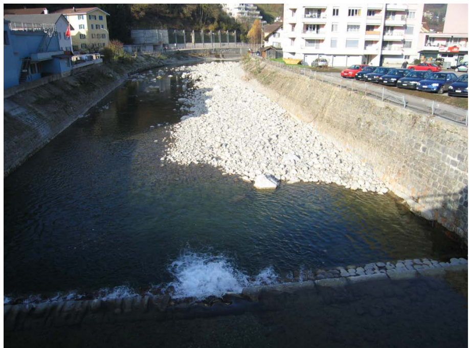
Abb. 43 Kleine Emme Abschnitt 4, oberhalb Wolhusen, Blick flussabwärts
