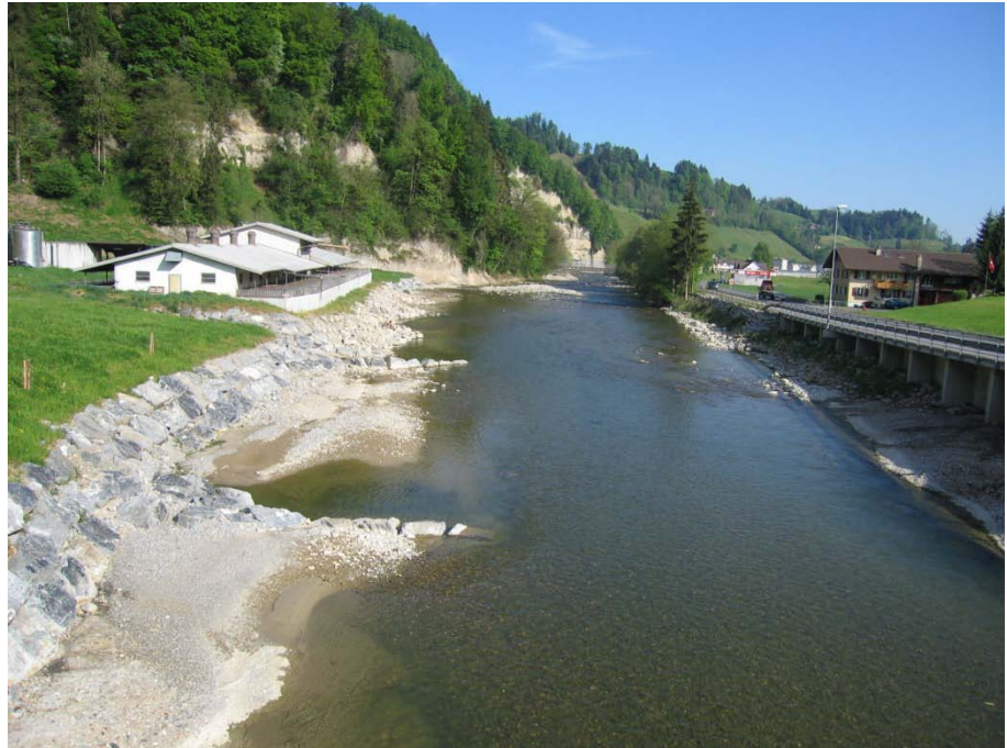
Abb. 42 Kleine Emme Abschnitt 4, oberhalb Wolhusen, Blick flussabwärts
