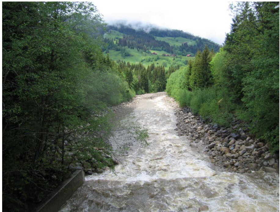
Abb. 127 Brücke Kantonsstrasse, Blick flussabwärts
