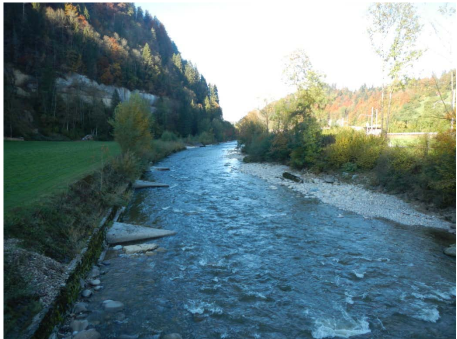
Abb. 49 Kleine Emme Abschnitt 5, unterhalb Zufluss Grosse Fontanne, Blick flussabwärts
