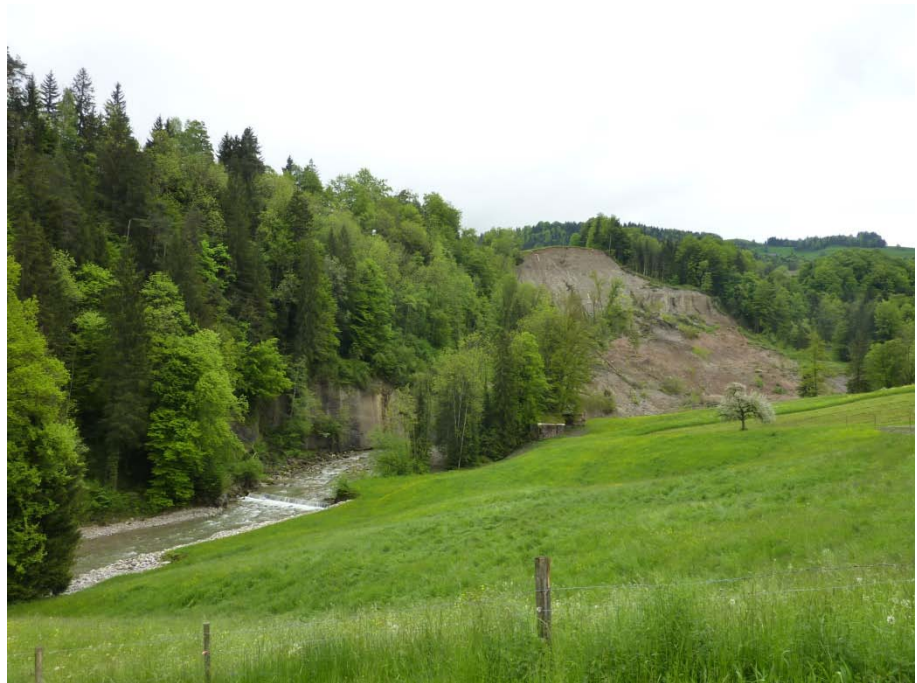
Abb. 68 Rümliq Abschnitt 2, Rutschung Holzguet, Blick flussaufwärts
