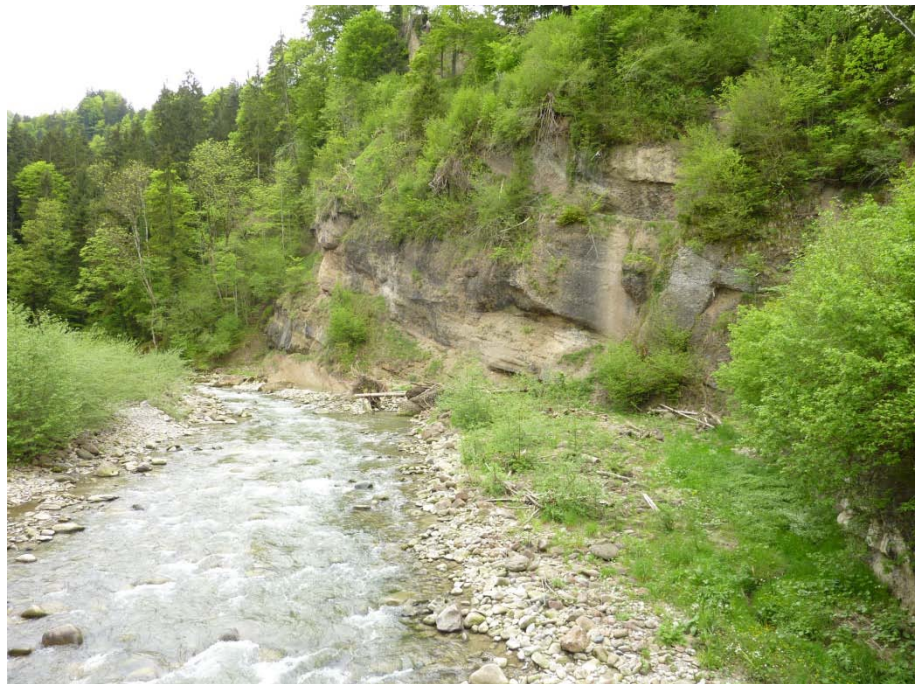
Abb. 67 Rümliq Abschnitt 2, Munistei, Blick flussaufwärts
