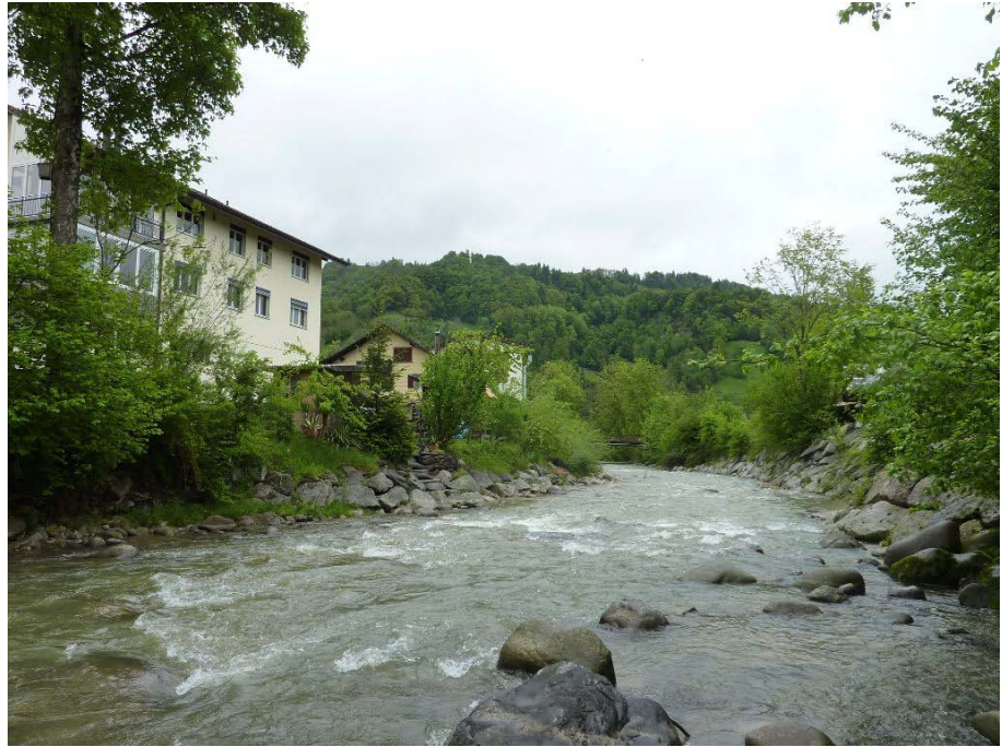
Abb. 63 Rümliq Abschnitt 1, oberhalb Strassenbrücke, Blick flussabwärts
