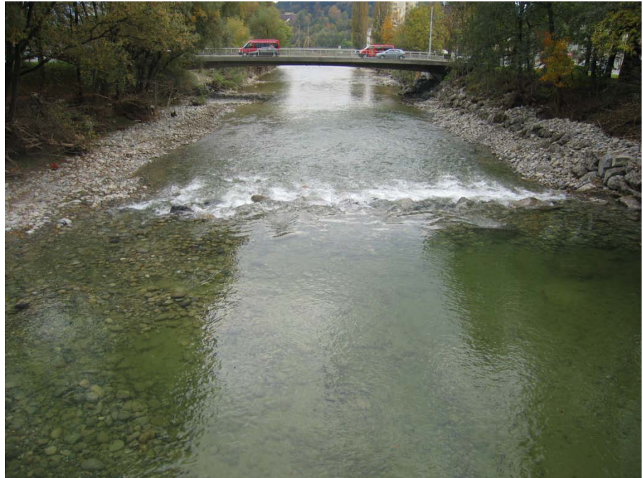
Abb. 27 Kleine Emme Abschnitt 1, Zollhausbrücke, Blick flussabwärts
