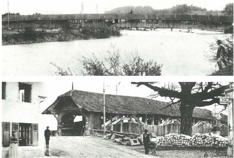
Abb. 29 Kleine Emme Abschnitt 1, alte Zollhausbrücke (erbaut 1785, Spannweite 137m, Abbruch 1902)
