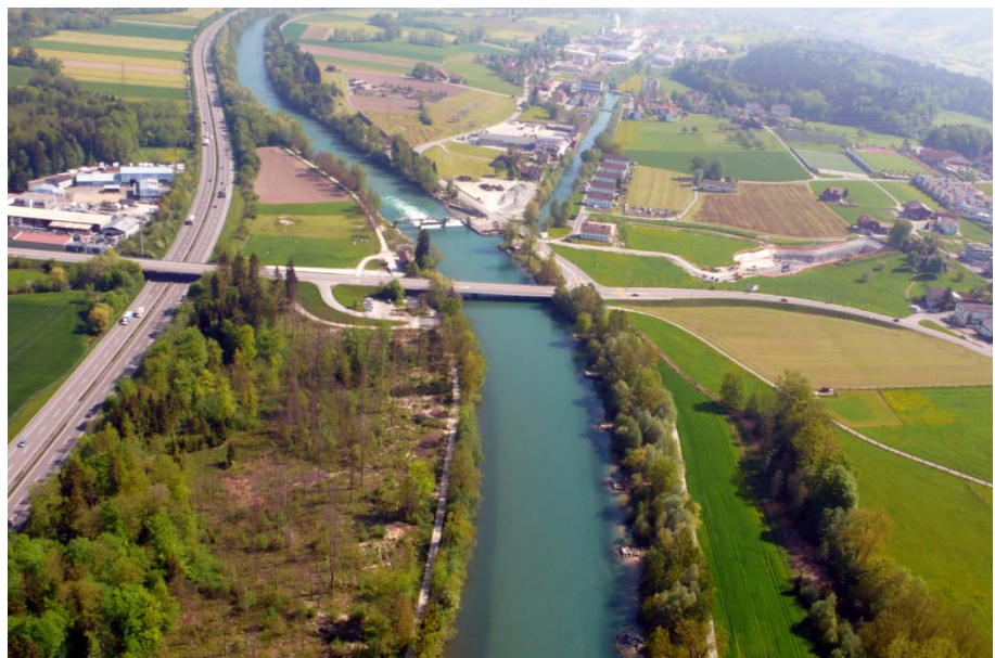
Abb. 11 Reuss, Perlen, Blick flussabwärts
