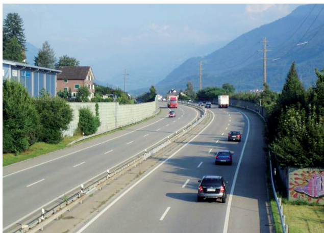
Abbildung 1: Bestehende ältere Lärmschutzwände
