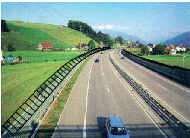
Abbildung 3: Lärmschutzwände mit PVA (Fotomontage)
