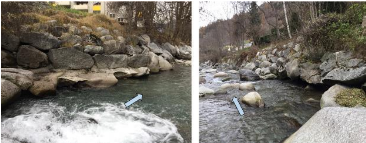
Image 5-13 Enrochements bétonnés à l'aval du seuil (aval Bourgeal)
