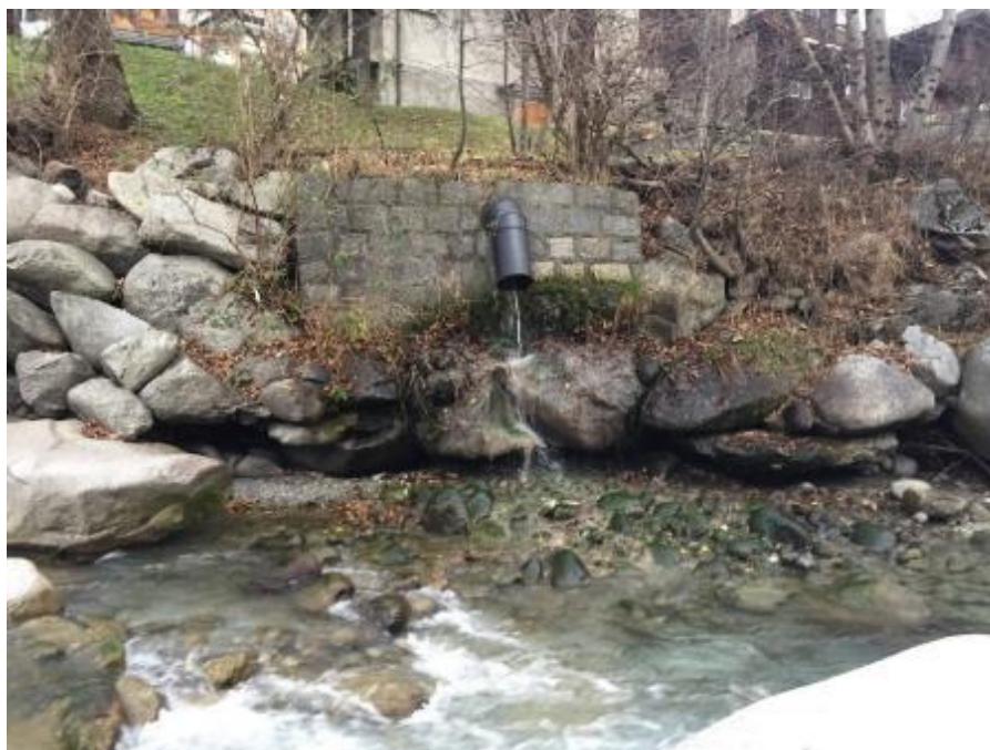
Image 5-7 Incision en rive gauche à l'aval de la passerelle de Podemainge
