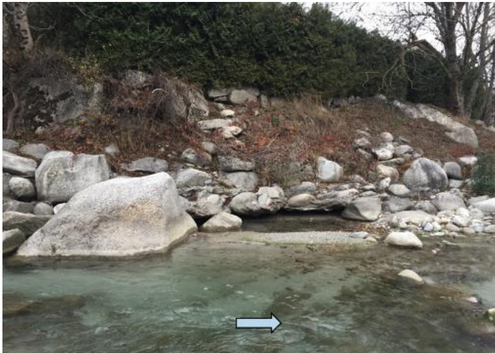
Image 5-8 Incision de la berge bétonnée en rive gauche
