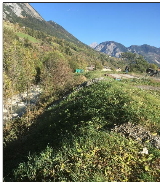
Image 6-2 Secteur amont – Tronçon 1 - Rive droite
