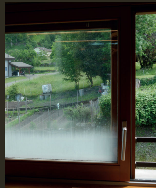
PORTE À LEVAGE ETAGE 2
